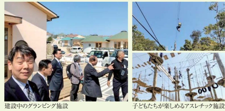
建設中のグランピング施設
